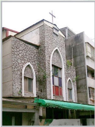
迦南堂施工前
