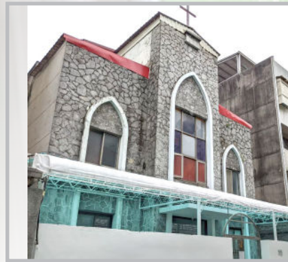
迦南堂施工後
